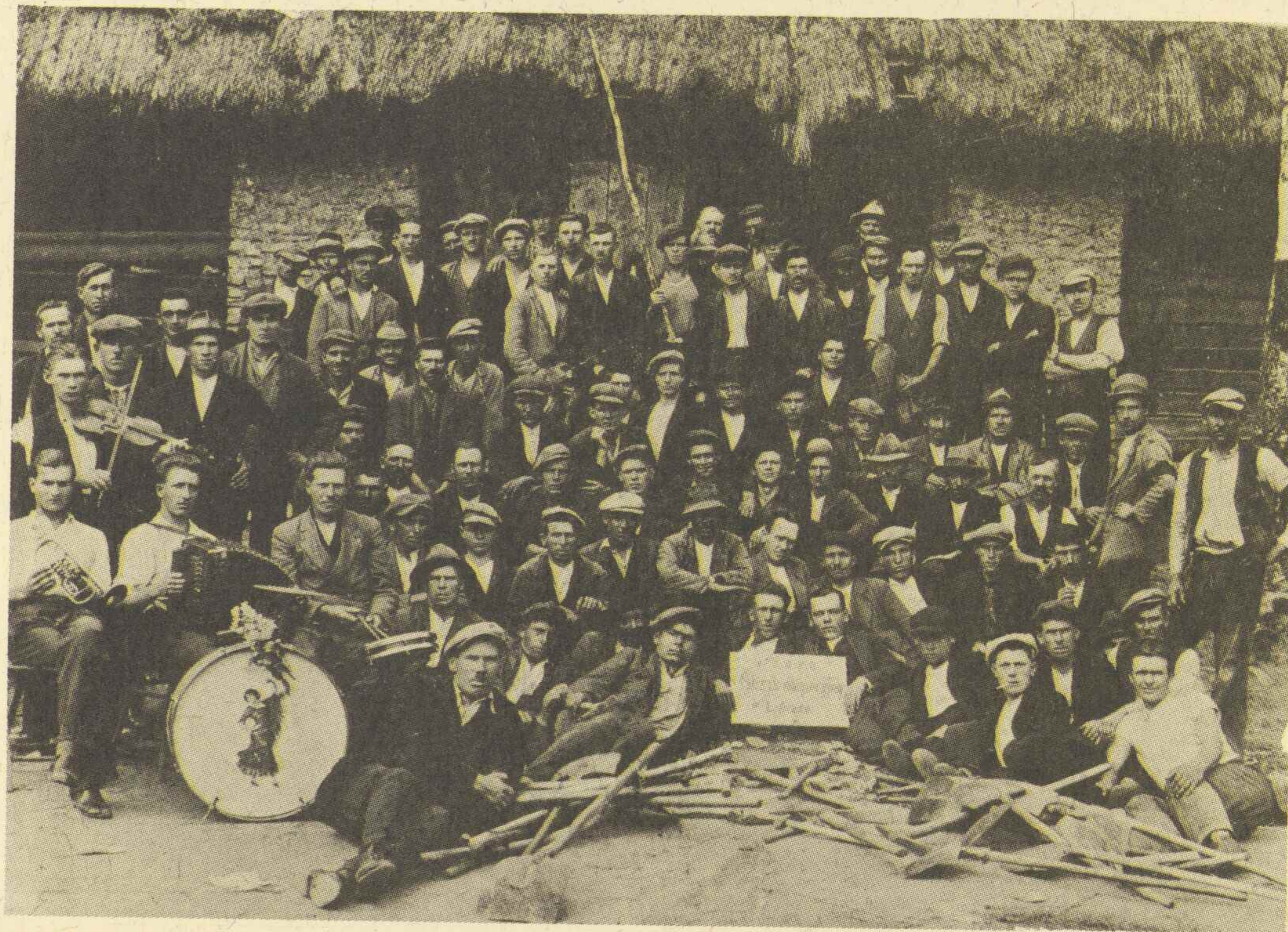
Strajk okupacyjnych robotników zatrudnionych przy budowie dróg w Libiążu prowadzonych przez władze powiatowe z funduszu dla bezrobotnych. 15 czerwca 1935 r. Fot. Jan Korpala Nad. STANISŁAW PAWELA z Libiąża. Identyczne zdjęcie nadesłał FRANCISZEK KANIBÓRKA z Libiąża Nagrody Polskiego Towarzystwa Historycznego
