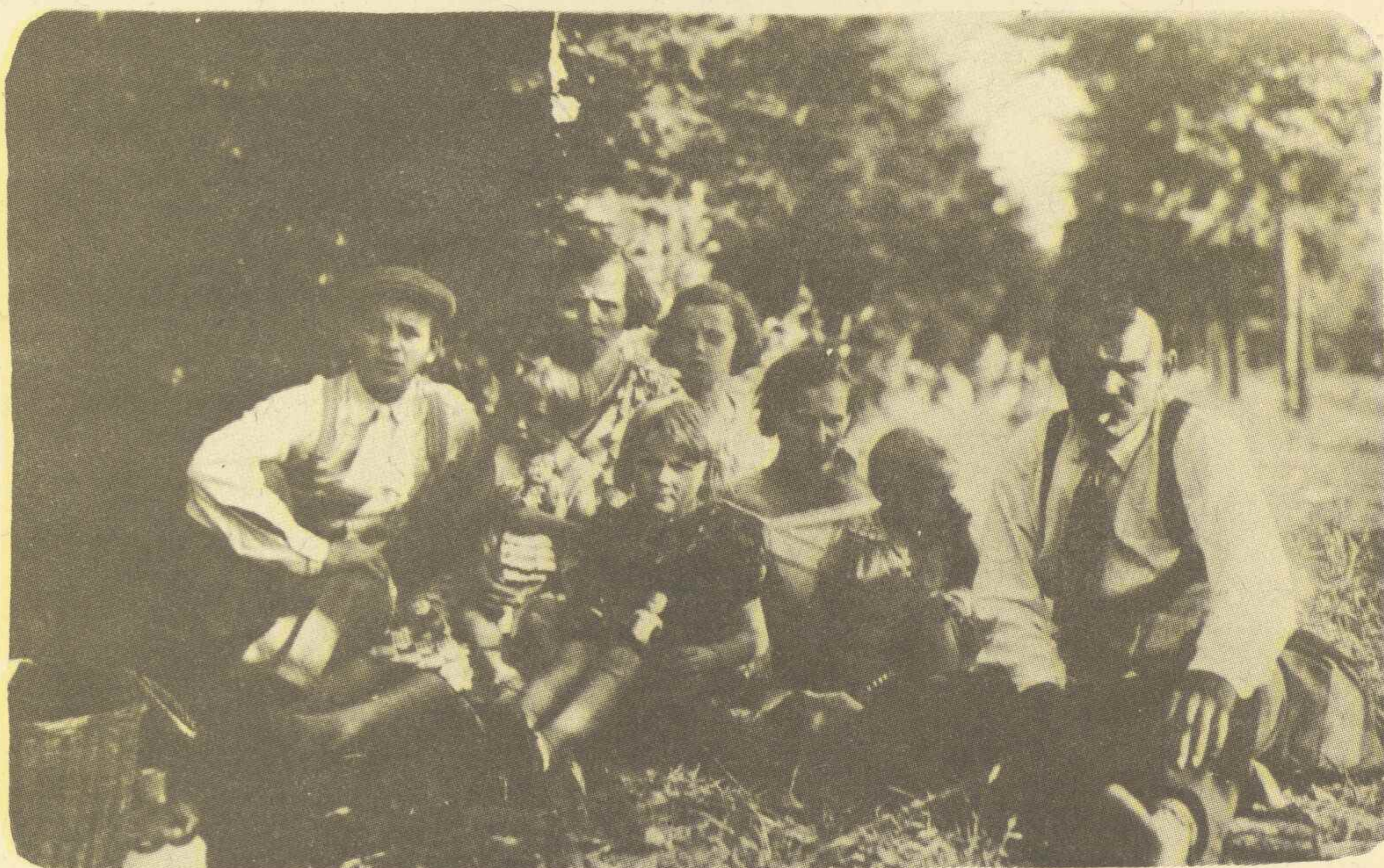
Amatorskie zdjęcie rodziny murarza warszawskiego zrobione w 1939 r. na majówce w Zielone Świąta w Młocinach pod Warszawą. „W dwudziestym roku ojciec mój wrócił z Rosji do kraju, do Warszawy z całą rodziną (...) budował Sądy na Lesznie, dzisiejszy gmach „Ekspresu Wieczorne-go” w Alejach, Dworzec Główny i in.” Nad. ZYGMUNT OBIEŚŁO z Ursusa Nagroda Polskiego Związku Inżynierów i Techników Budowlanych
