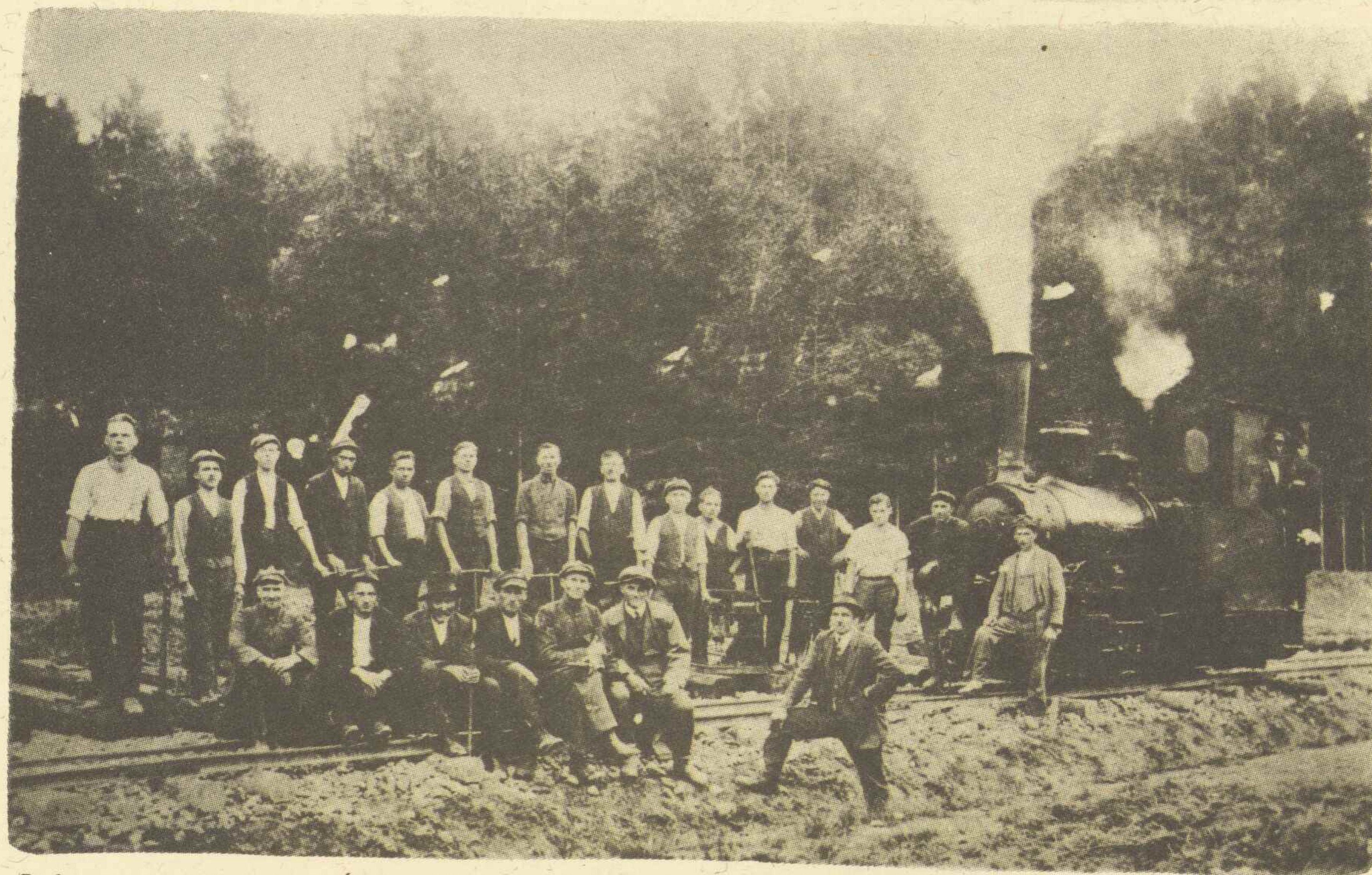
Budowa magistrali węglowej Śląsk - Gdynia w latach 1927-1931.
