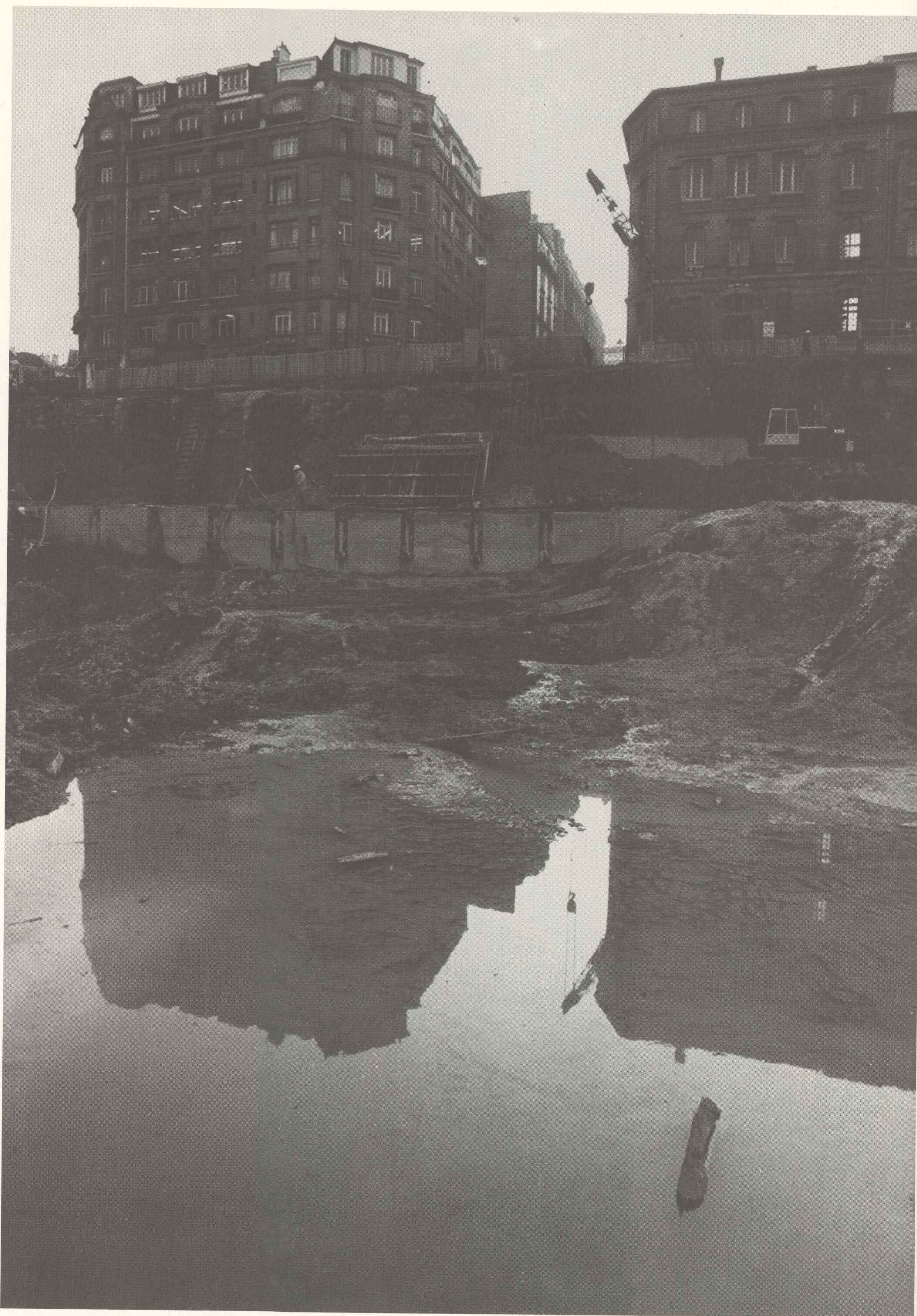
Budowa Centrum Georges Pompidou, 1972
