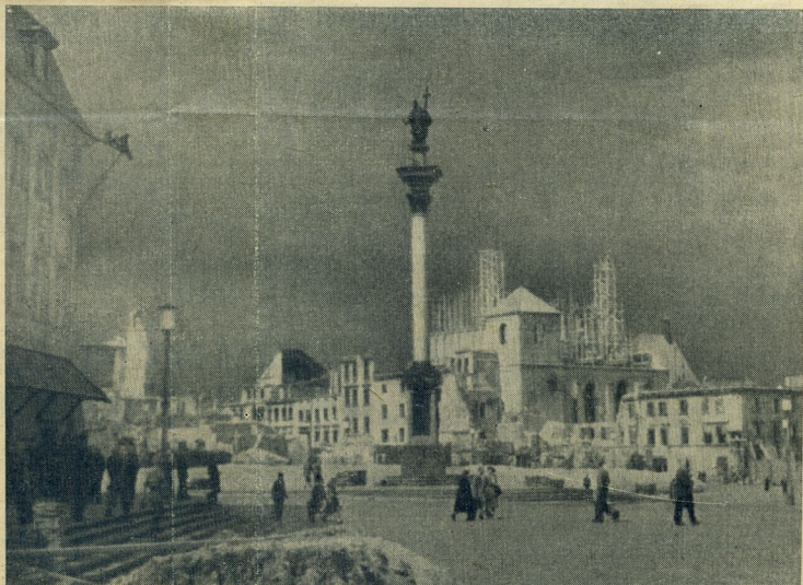
Haneman Eugeniusz — Łódź. „Plac Zamkowy w odbudowie”.
