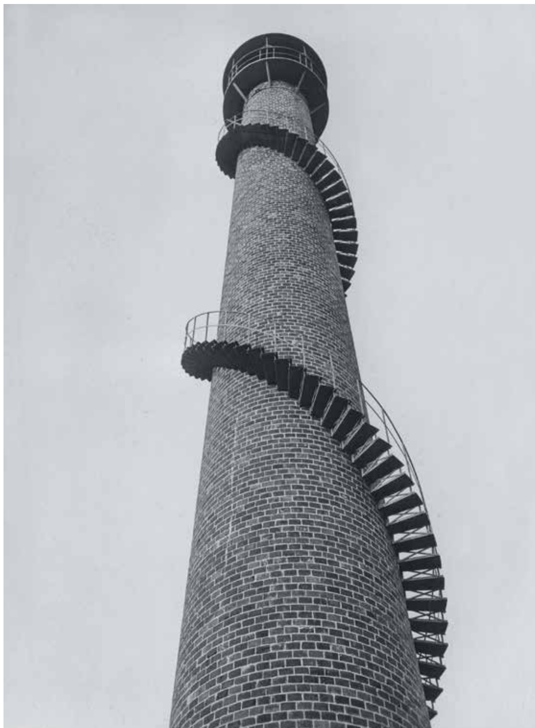
Komin kotłowni na osiedlu WSM Żoliborz, Warszawa, lata trzydzieste XX wieku, Izba Historii WSM
