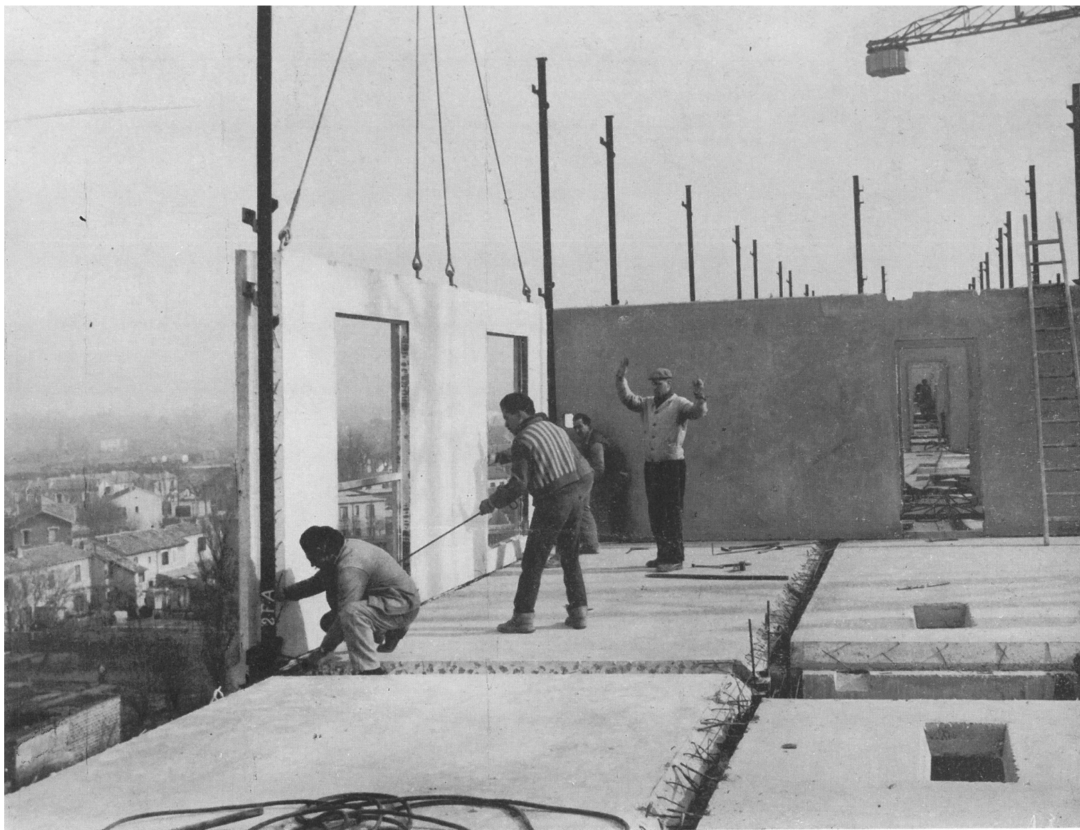
Estiot e f Cie, Montaż elementów prefabrykowanych
