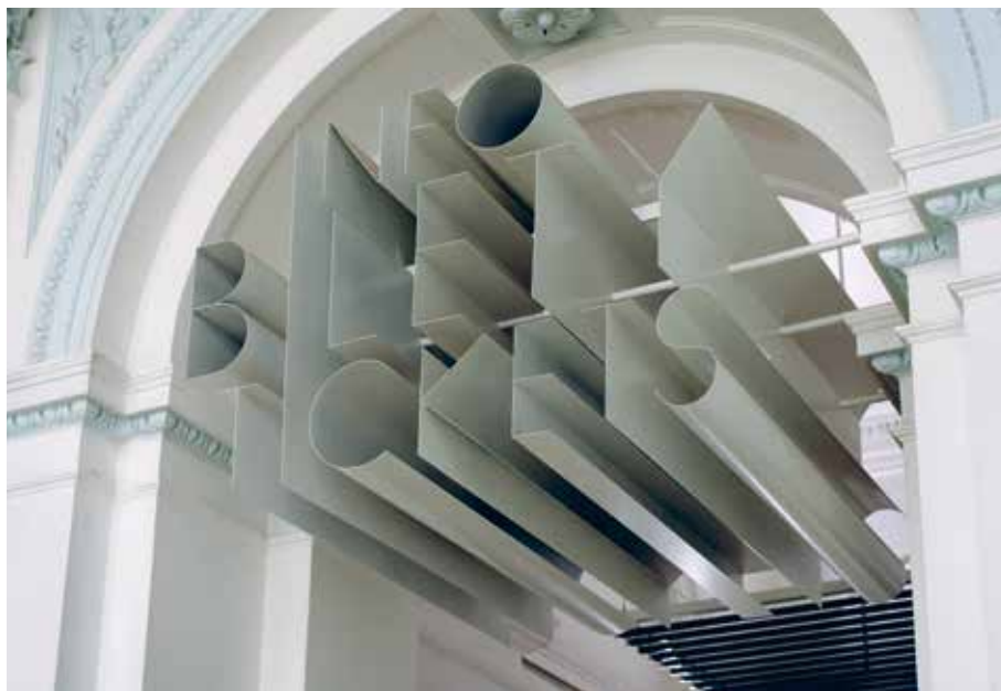
Hol główny, przejście do informacji. Fot. Maciej Landsberg
